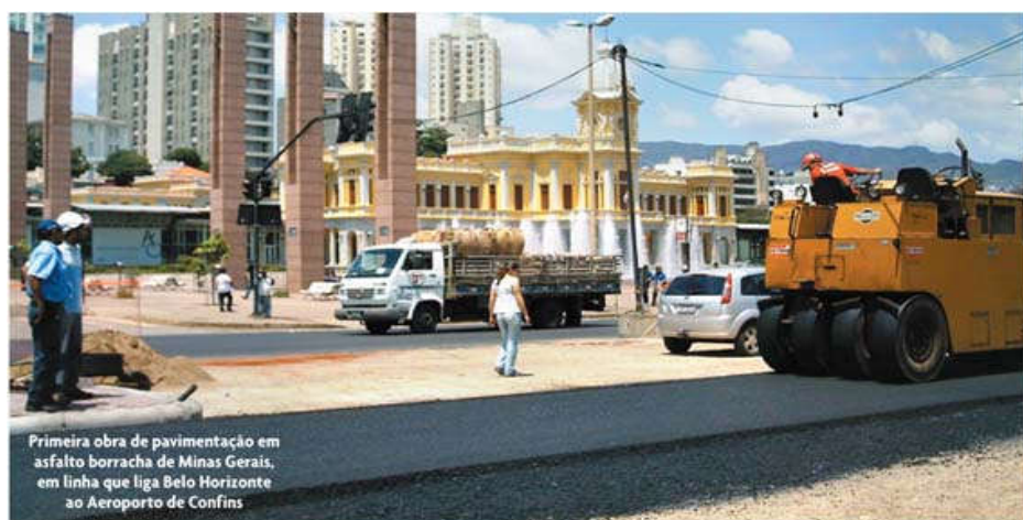
Figura 3.6: Primeira obra de asfalto-borracha em Minas Gerais/Brasil Fonte: www.pmbh.gov.br . Acesso em 2 de maio de 2017.
